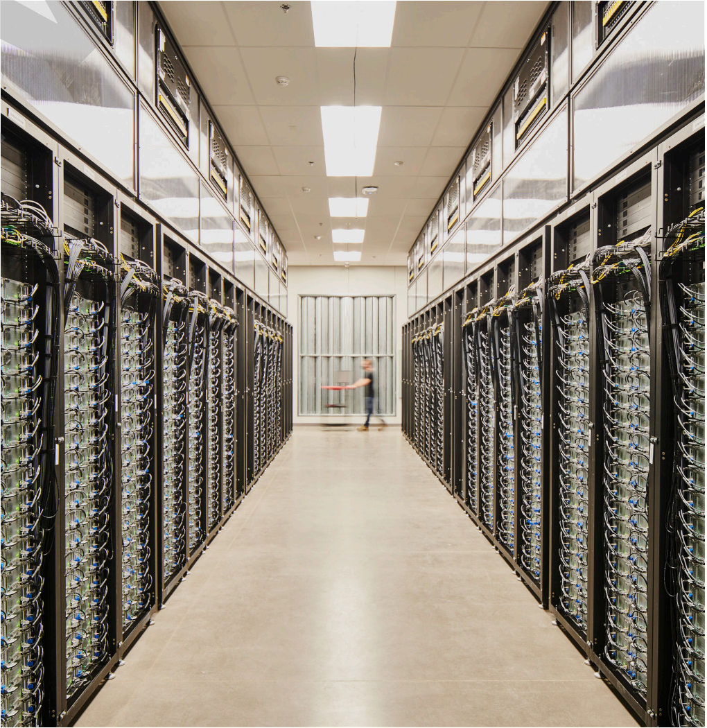
Le data center d'Apple de Reno, ouvert en 2012, profite du climat doux en refroidissant ses serveurs avec de l'air extérieur chaque fois que possible.
